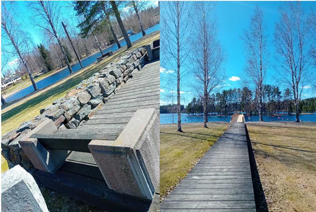
Kävelysillan levähdyspaikat kivimuureineen ja näkymä kohti Sikosaaren siltaa.
